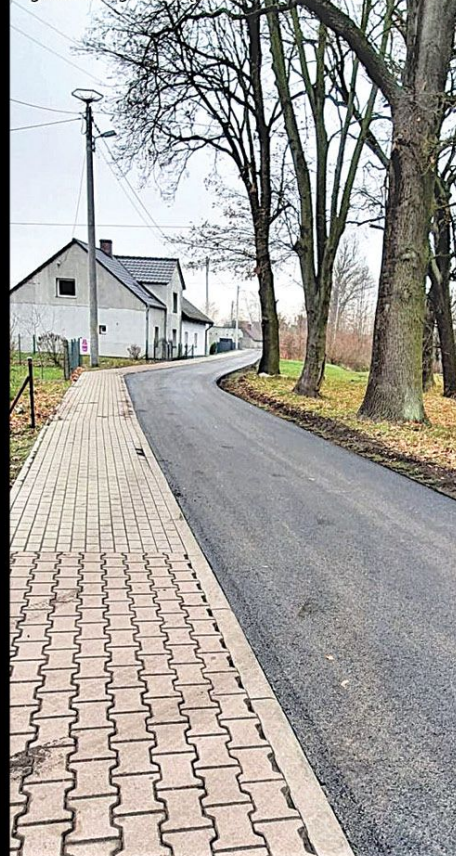
W Słocinie przebudowana zostanie gminna droga wewnętrzna.
