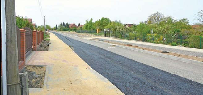
Budowa drogi gminnej na odcinku od ul. 22 Lipca 1807 do ul. Moniuszki w Kozuchowie.
