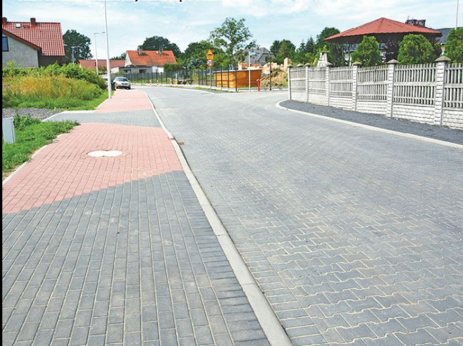
Ulice Sienkiewicza i Reymonta po remoncie.
