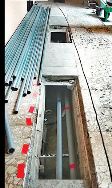
Wymiana instalacji centralnego ogrzewania w zamku.
